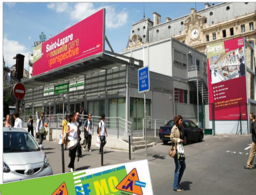
Communication rénovation Gare Saint-Lazare
